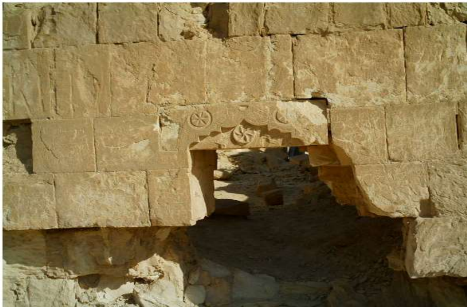
صورة رقم (2) فتحة الصهريج من الخارج أسفل الواجهة الجنوبية الشرقية صوير الباحث
