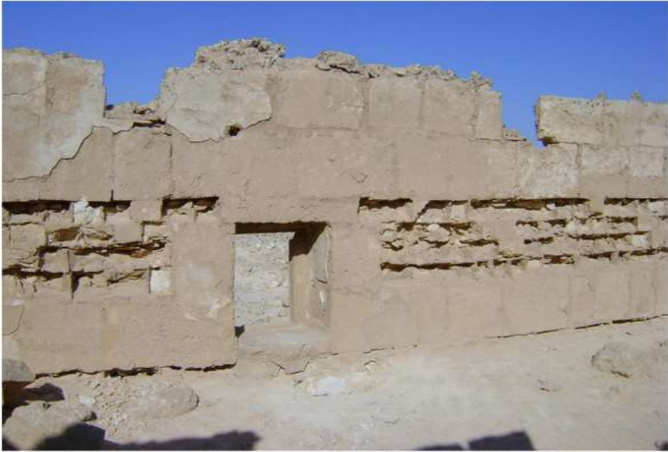
صورة رقم (8) الواجهة الجنوبية الغربية لجامع قلعة صدر(الجندي) تصوير الباحث
